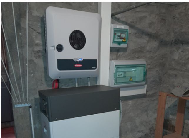
/ Inversor Fronius Primo GEN24 Plus y batería BYD para el almacenamiento de energía
